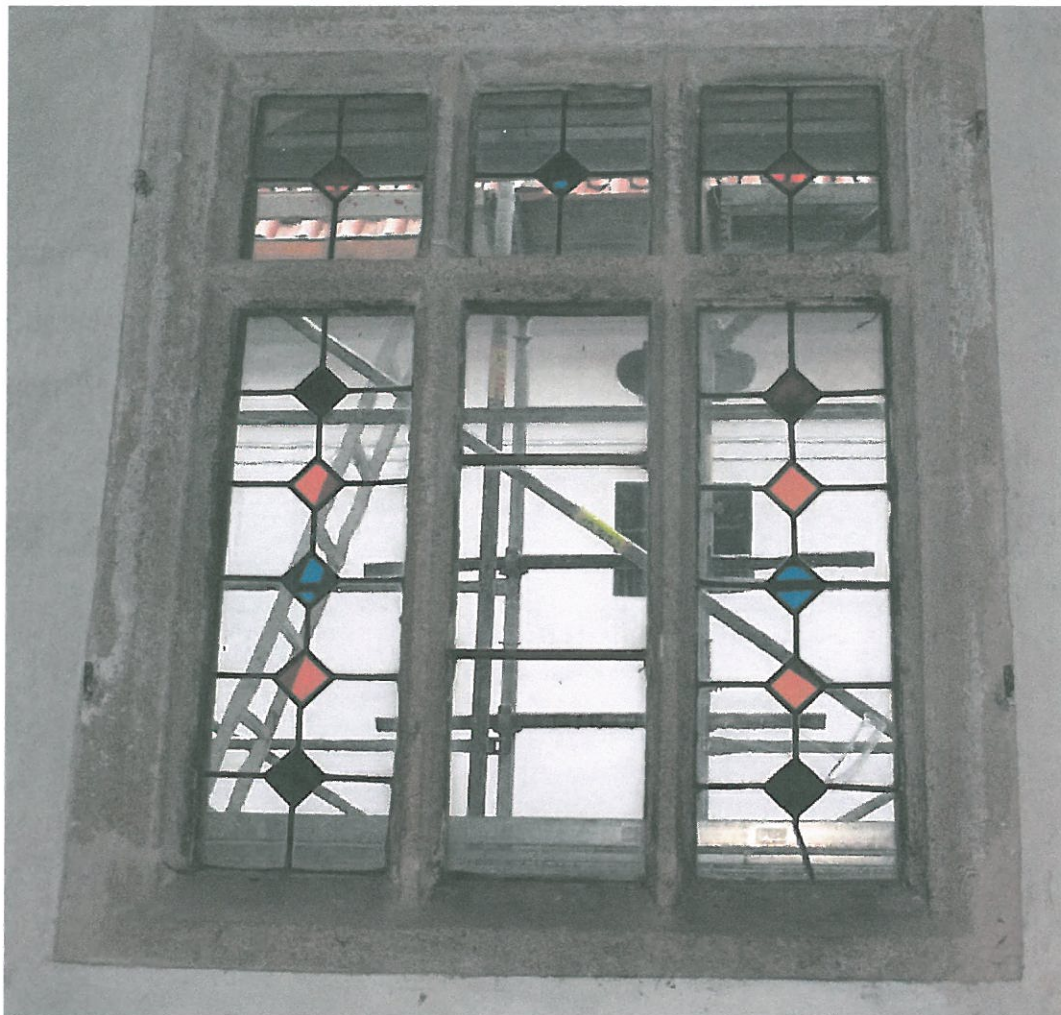
Okno OS/7 stav před restaurováním- celkový pohled na okno. Absence středové části vitráže.
